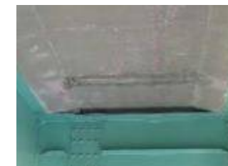
コンクリート床版の損傷状況
