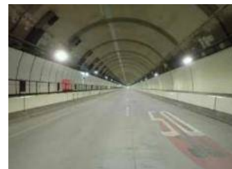
東山トンネル
