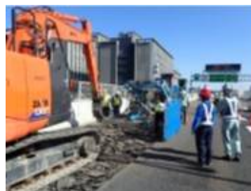
リフレッシュ工事
