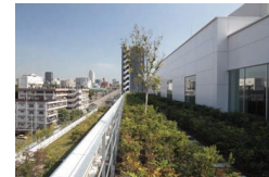
屋上庭園の設置 (Daiwa麻布テラス)
