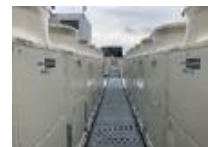
空調設備の更新 (Daiwa銀座ビル)
