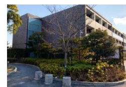
敷地内緑化の実施 (グランカー・サ緑地公園)
