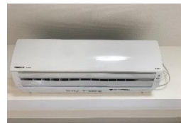
省エネ型エアコン設置 (TKフラッツ渋谷)
