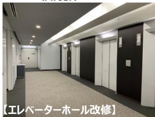
【エレベーターホール改修】
