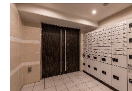
宅配ボックス設置 (グランカーサ大森海岸)
