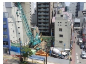
<着工時現場写真(2021年6月末)>
