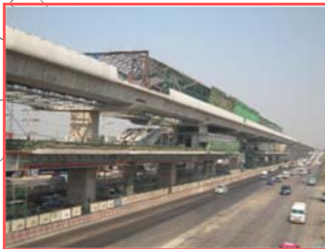
建設中の高架鉄道
