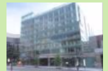
省エネ商業施設
