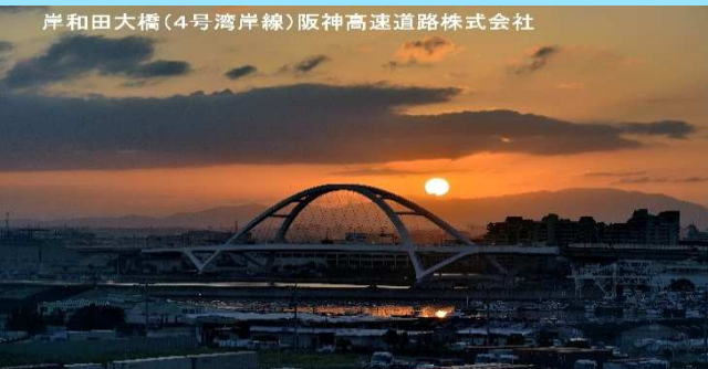
岸和田大橋(4号湾岸線)阪神高速道路株式会社
