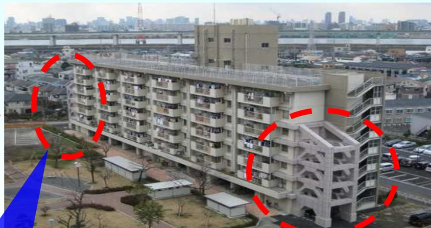
バトレス工法による耐震改修事例
